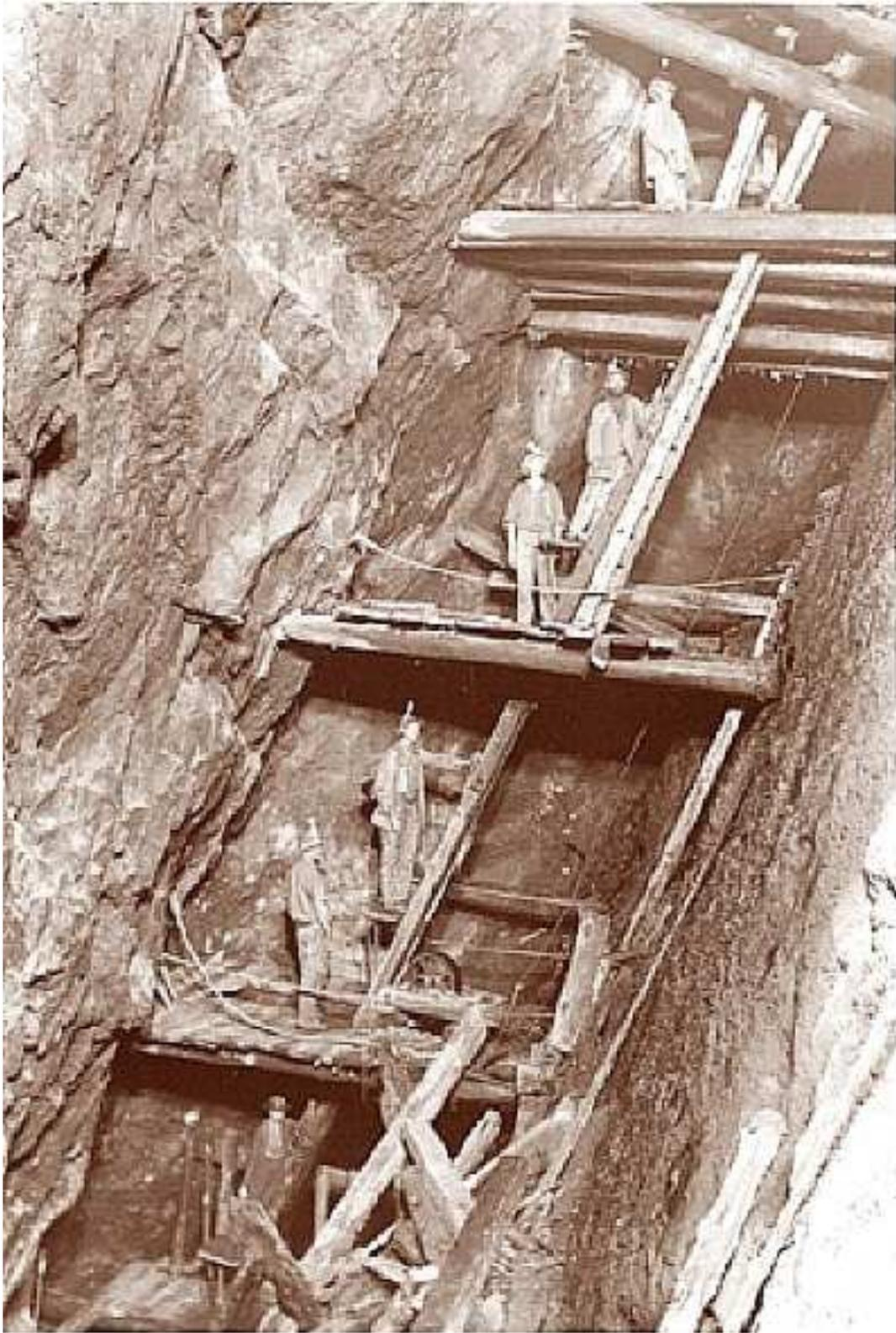
**Abb.7 : Die berühmte Fahrkunst der Dolcoath Mine in Cornwall /
