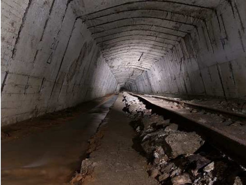
Abb. 32a : Heutiger Zustand des Weserstollens Quelle : www.untertage-uebertage
